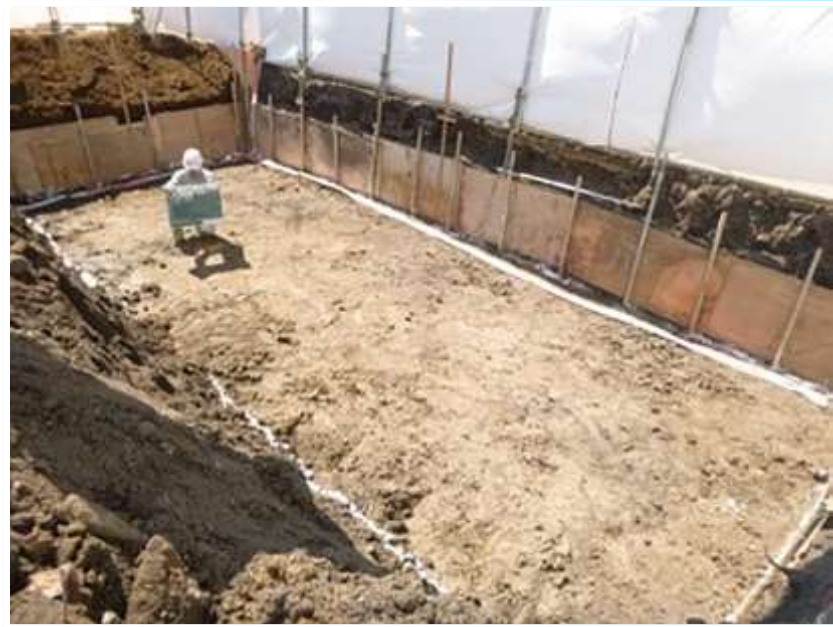
掘削除去工事
